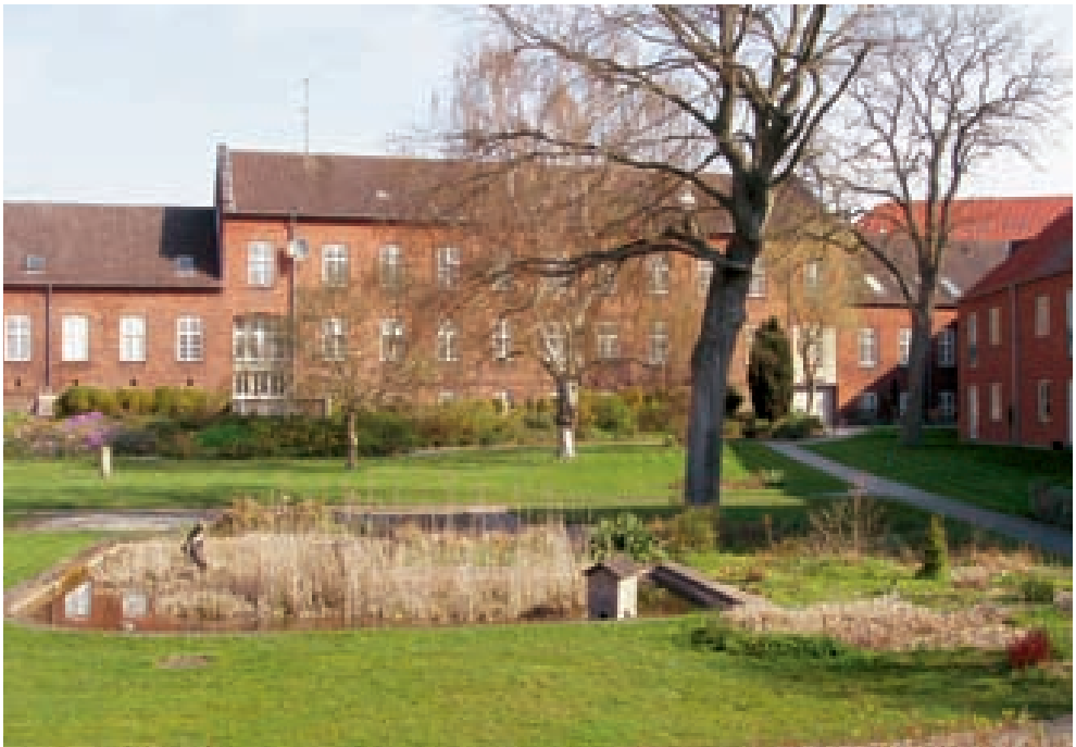
Facade mod syd set gennem haven.
